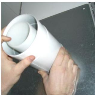
5. Pose du raccord concentrique d'amenée d'air comburant et de la plaque d'étanchéité
