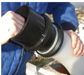
6. Fixation haute du tubage et de l'élément terminal
