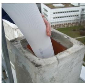
2. Introduction du tubage (ici en PP Ø 80) et mise en place des fixations, supports, centreurs
