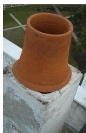
1. Dépose de l'élément terminal, ici mitron
