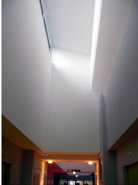
*Exemple de puits de lumière pour éclairer une circulation ((photographié un jour d'hiver, gris et pluvieux). Un tel système permet d'éviter l'éclairage artificiel durant la journée.*
