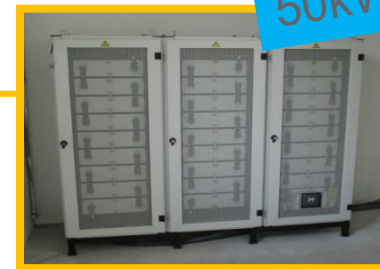
Stockage d'énergie sur batteries
