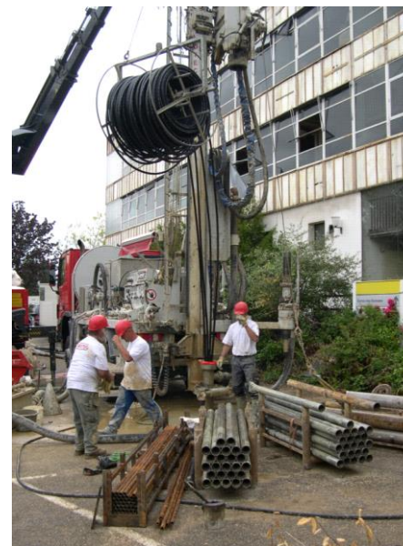
Installation d'une sonde
