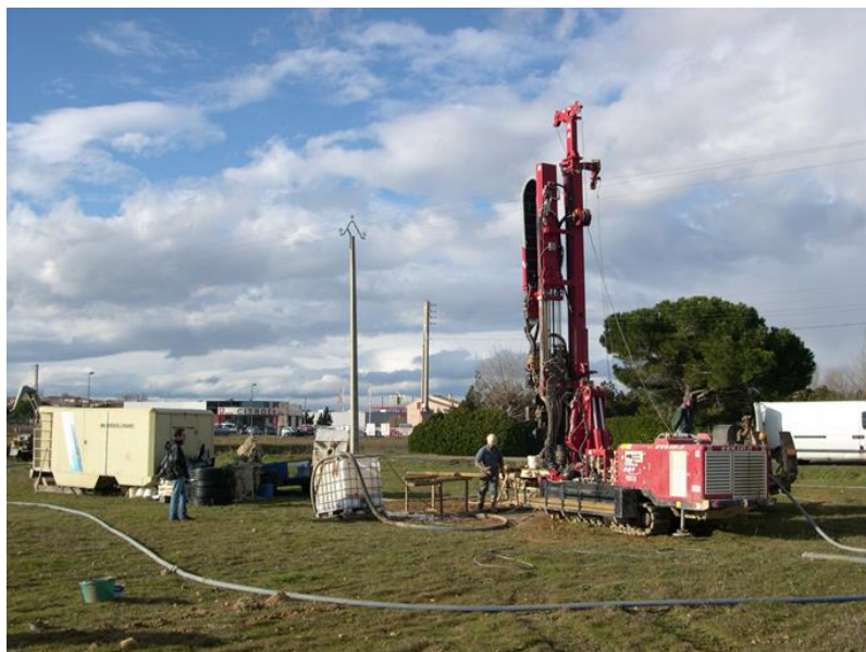
Atelier de forage géothermique
