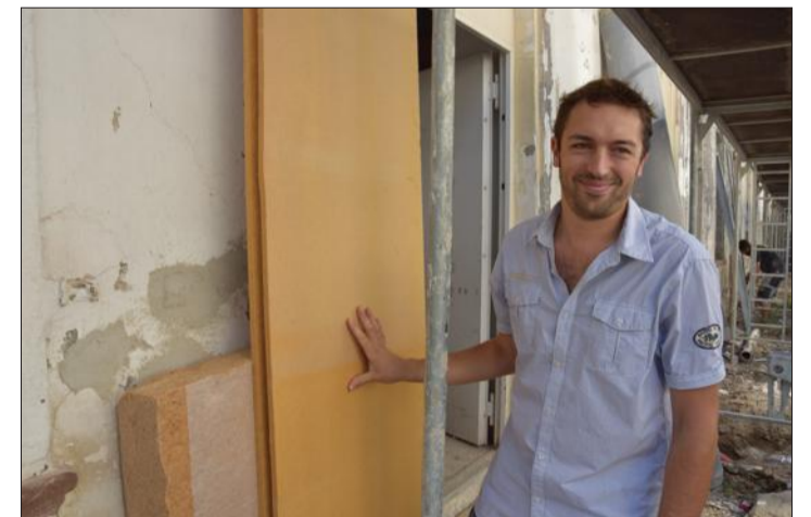
Jean-Baptiste Compin, devant la façade nord de l'édifice. Invisible depuis la rue, celle-ci sera isolée par l'extérieur, à l'aide de laine de bois.
