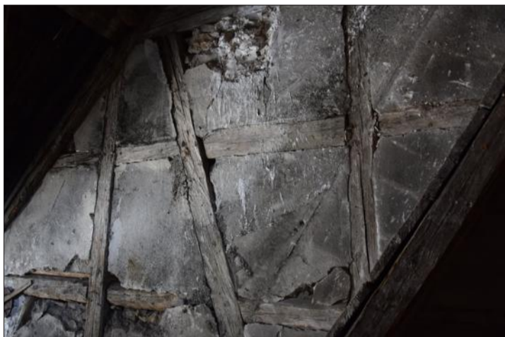
Les murs originaux de l'édifice, bâtis à l'aide de colombages, apparaissent encore sous les combles.
