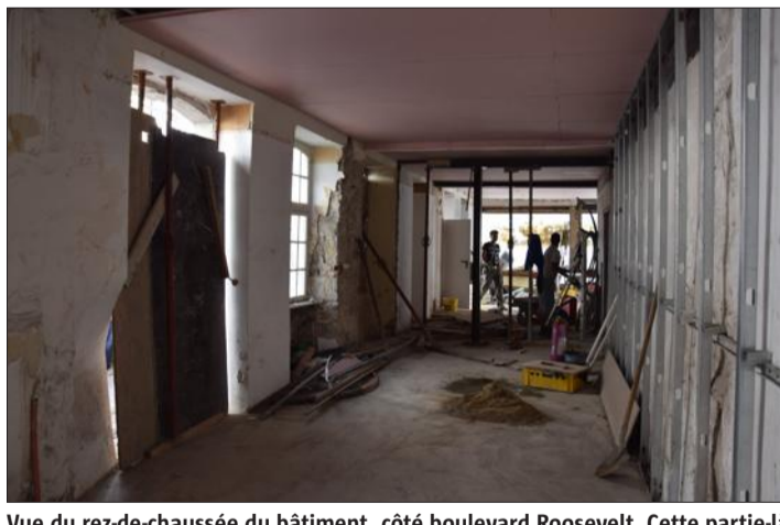
Vue du rez-de-chaussée du bâtiment, côté boulevard Roosevelt. Cette partie-là accueillera le nouveau cabinet de chiropraxie de Sophie Lauzzana, l'épouse de Jean-Baptiste Compin.
