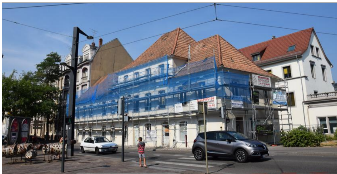
La manufacture Huguenin, bâtie en 1788, se trouve à l'angle de la rue Gutenberg et du boulevard Roosevelt. Débutés en juin dernier, les travaux de réfection s'achèveront normalement vers Noël.
