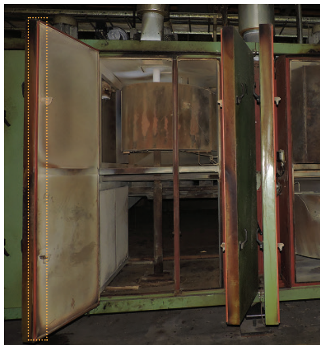
Joints neufs sur les portes d'un four de traitement thermique
