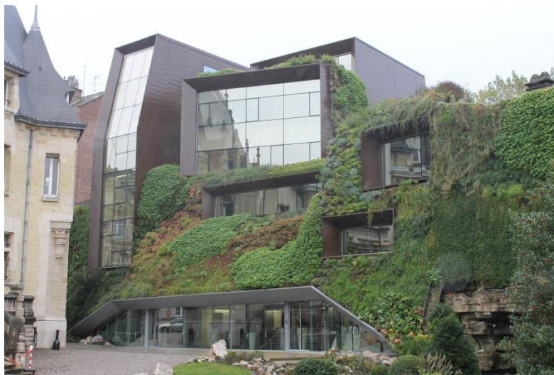
CCI AMIENS bâtiment HQE - façade VertiFlore®
