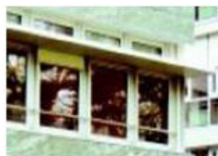
L'étagère à lumière est placée au dessus de la paroi vitrée, et d'autres vitres plus petites au-dessus
