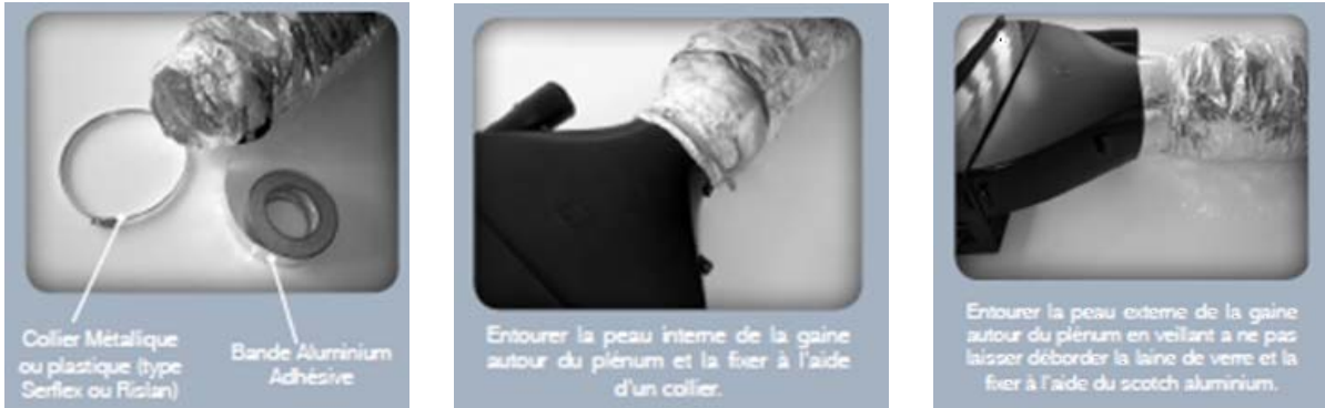
Figure 3 – Mise en œuvre du réseau de soufflage
