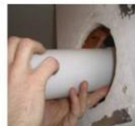
4. Conduit de raccordement vers la chaudière
