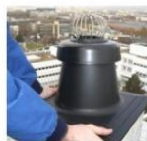
7. Pose de la sortie de toit et du dispositif anti-volatiles
