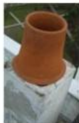
1. Dépose de l'élément terminal, ici mitron
