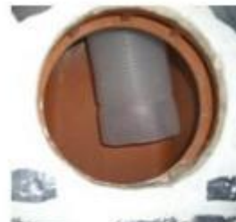
3. Arrivée au point de raccordement du tubage vers la chaudière
