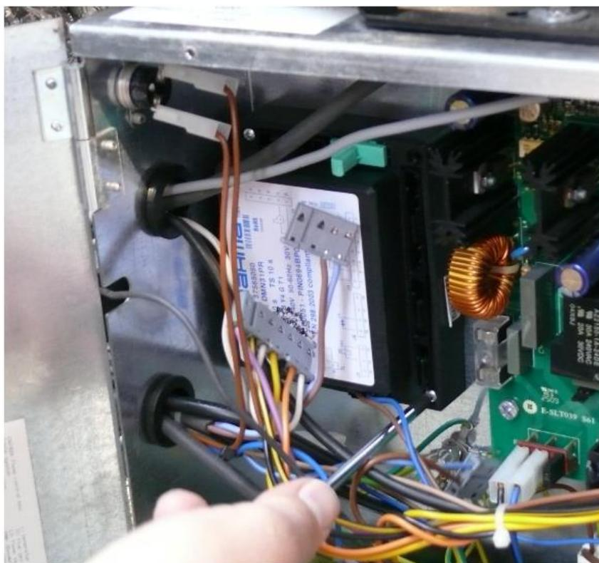
Débrancher les connectiques du boîtier
