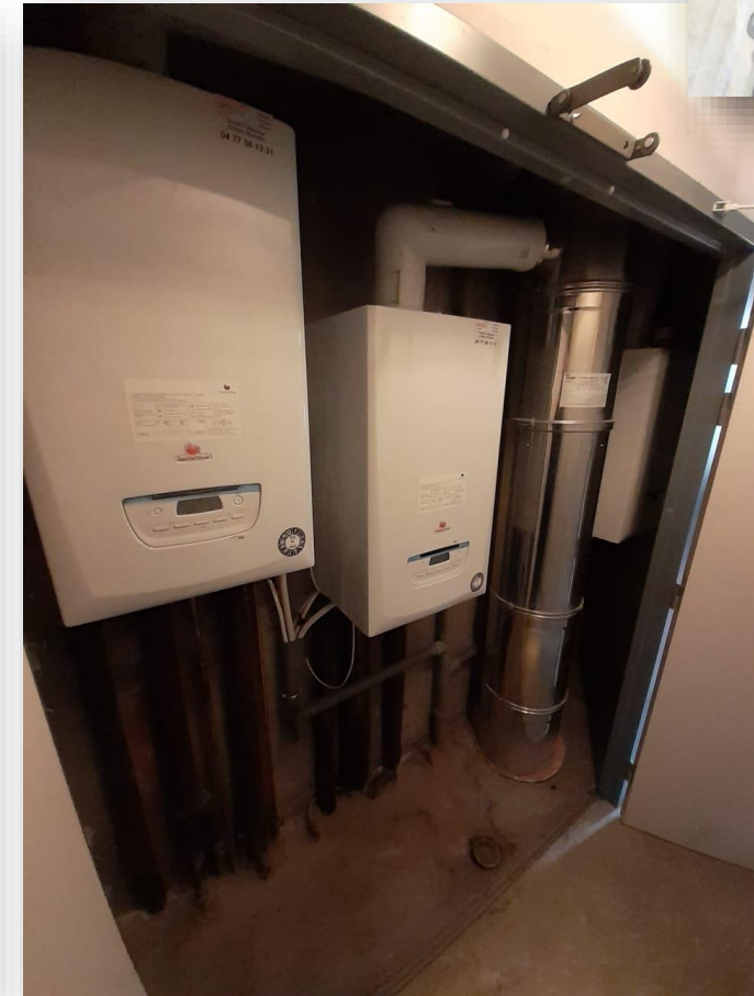
Chaudières + conduit 3CEp + ventilation + tiges après-compteurs
