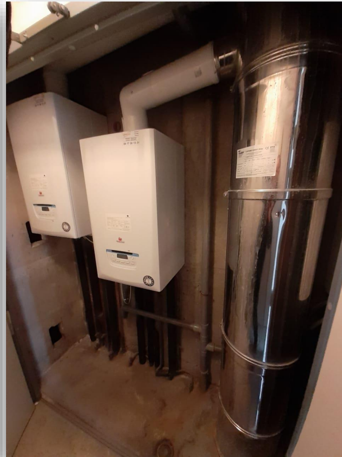
Chaudières + conduit 3CEp + ventilation + tiges après-compteurs
