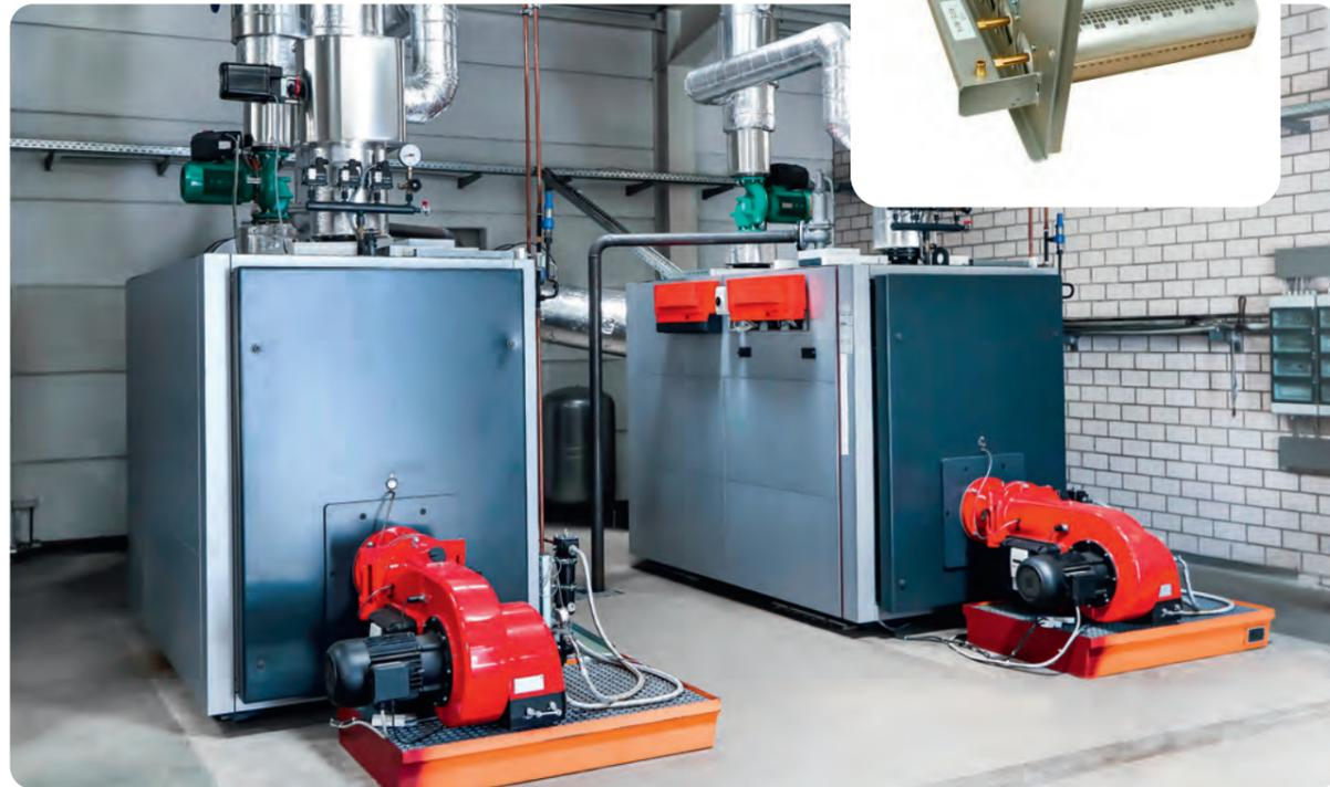
Il existe des chaudières avec des corps de chauffe en fonte ou en acier. Les anciennes chaudières sont généralement en fonte tandis que les chaudières plus récentes sont en acier ou en inox.
